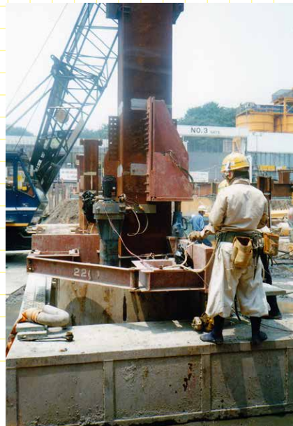
▲鋼製柱建込み治具例
